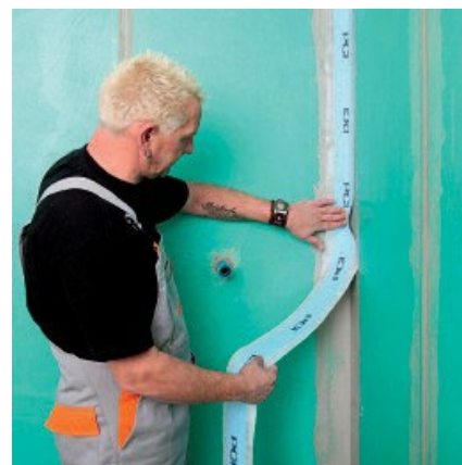
Вручную выровняйте гидроизоляционную ленту PCI Pecitape 120 и слегка надавите...
