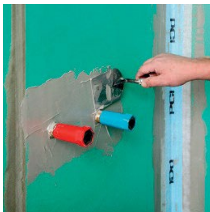
Перед монтажом гидроизоляционного воротника PCI Pecitape 10x10 также нанесите достаточное количество гидроизоляционного материала вокруг выходов водопроводных труб.
