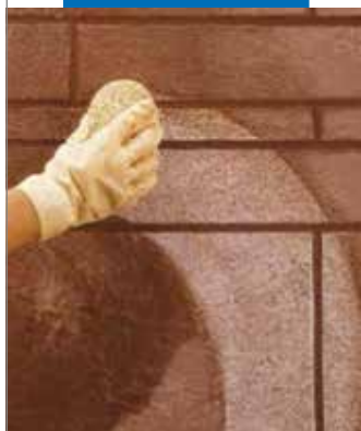
Окончательная очистка плитки с помощью губки
