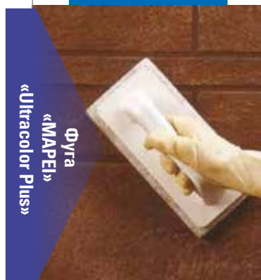
Заполнение швов на стене раствором Ultracolor Plus с помощью резинового шпателя
