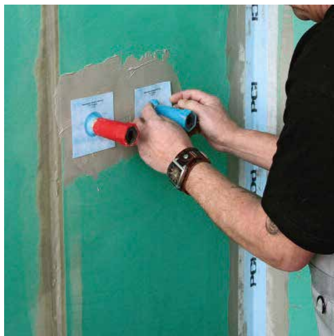
2. В местах прохождения труб через стену поместить PCI Pecitape 10×10 и покрыть составом Lastogum PCI (серого цвета).
