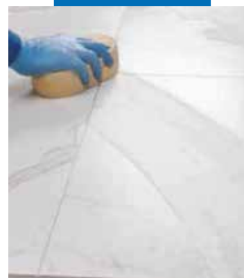
Окончательная очистка плитки губкой
