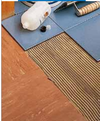
Укладка на старое ПВХ покрытие
