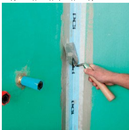
... вдавите ленту, используя небольшое давление.
