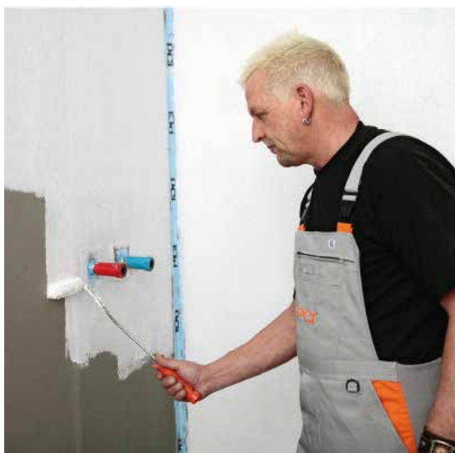
5. Нанести второй защитный слой PCI Lastogum (белого цвета), выждав время на испарение (прибл. 1 час). Первый слой PCI Lastogum (серого цвета) не должен просвечивать, иначе потребуется еще один слой.
