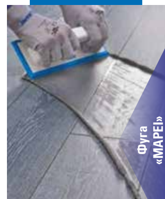
Очистка плитки теркой Scotch-Brite®
