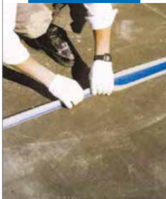
Пример гидроизоляции деформационного шва на террасе
