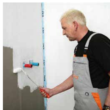
Неразбавленный PCI Lastogum наносится на обрабатываемую поверхность валиком, кистью или шпателем
