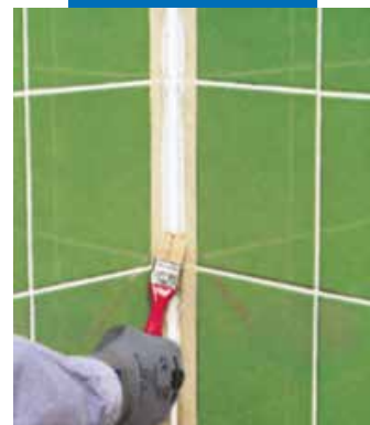
Заглаживание шва кисточкой, смоченной в мыльной воде
