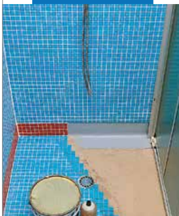
Гидроизоляция и укладка облицовки в душевой кабинке
