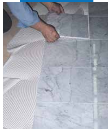
Укладка мрамора Carrara на деревянное основание, используя белый Keralastic
