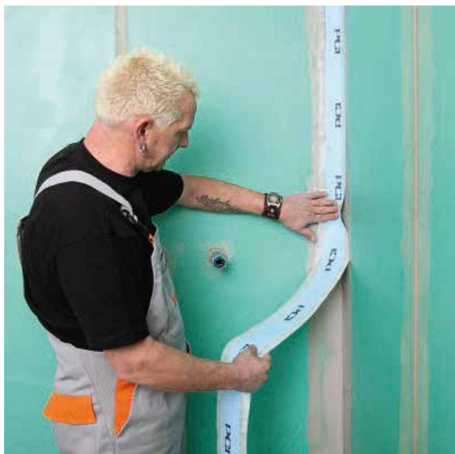
3. Зафиксировать PCI Pесitape120 с помощью PCI Lastogum (серого цвета) в угловых соединениях и соединениях пола со стенами.
