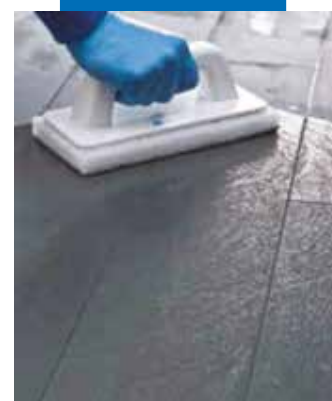
Окончательная очистка плитки губкой
