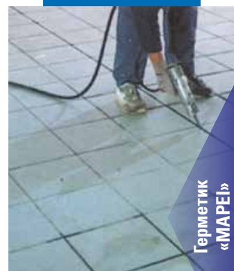
Герметизация швов в плитке посредством Mapesil AC
